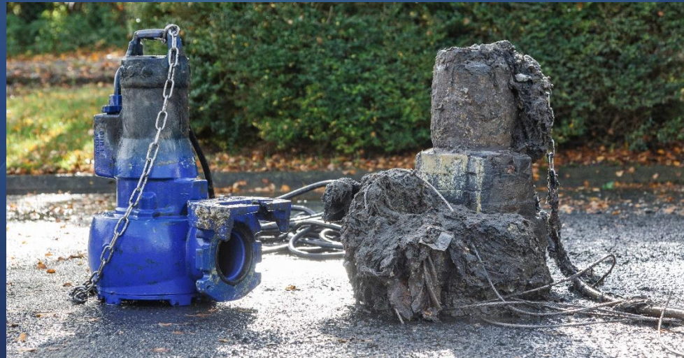
Exemple de pompe endommagée et de pompe normale
